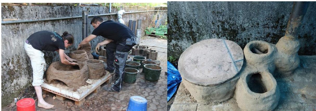
Abbildung 7: Bau des Chigr Fechi (links) / Grundmodell des Chigr Fechi (rechts)
