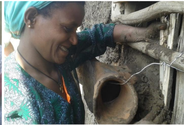
Das Outlet wird befestigt
