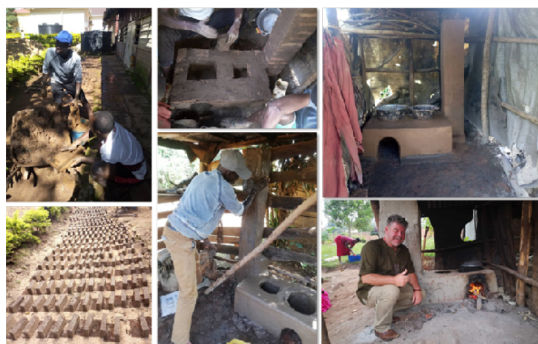
Vorbereitung und Produktion der Ziegel und Bauelemente zum Bau der ersten Öfen
