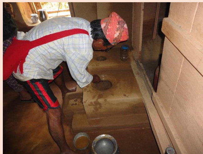
Letztes Handanlegen und der gesunde Ofen ist fertig
